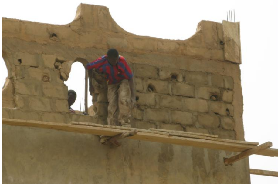
Maçonnerie acrobatique a plus de 7 m du sol !
